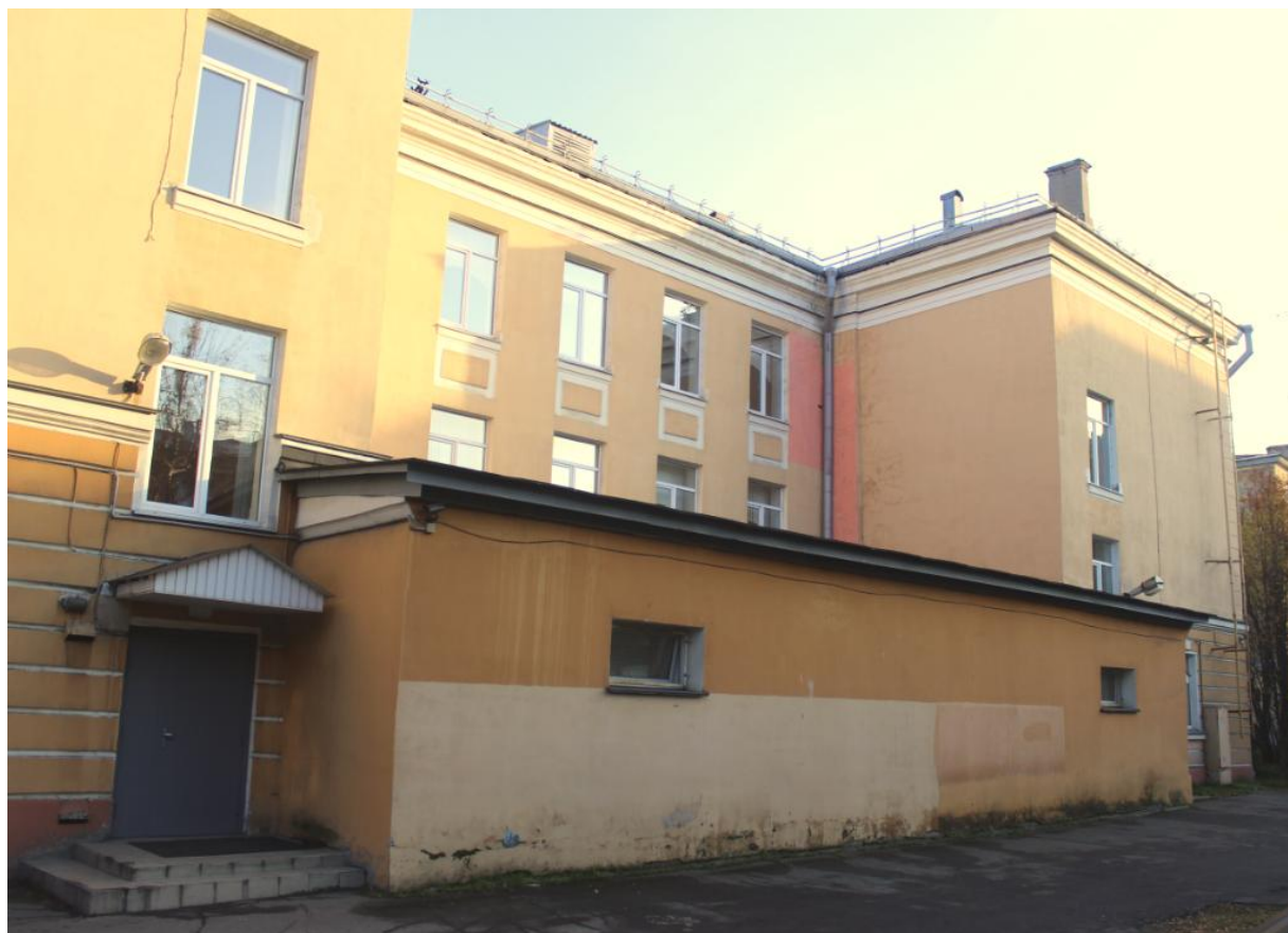
Фото 6. Юго-западный фасад. Общий вид.
