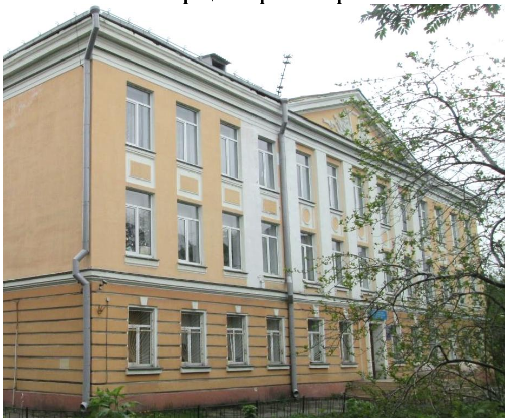
Фото 1. Северо-восточный фасад, восточная часть.
