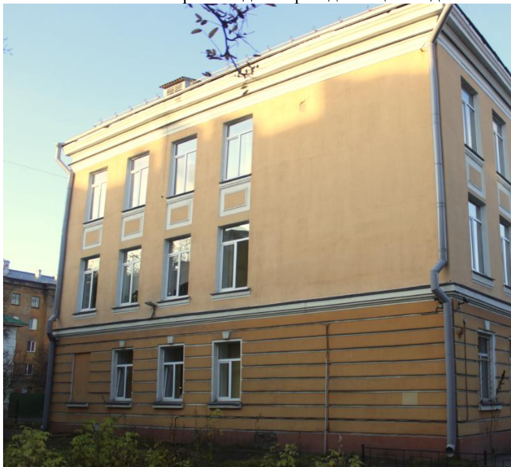
Фото 5. Юго-восточный фасад. Общий вид.
