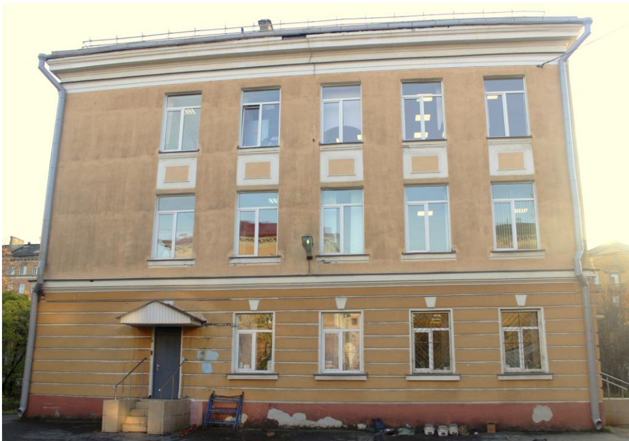
Фото 4. Северо-западный фасад. Общий вид.
