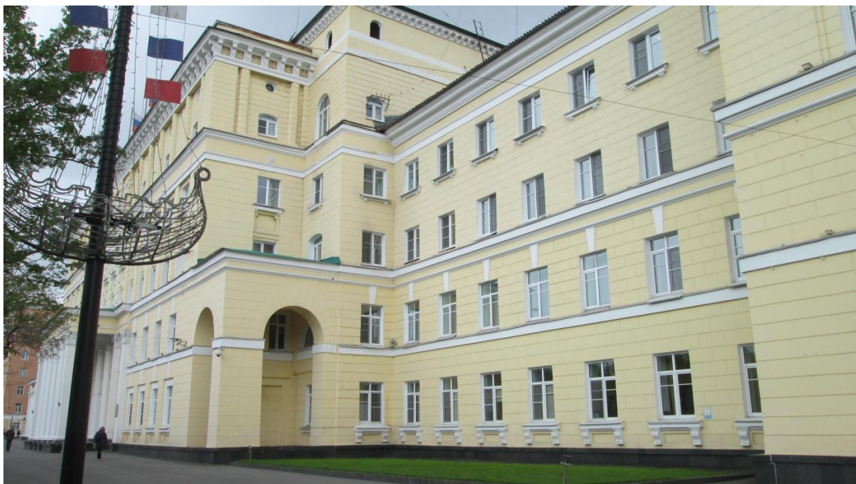
Фото 3. Центральная часть западного фасада. Вид с юго-запада.
