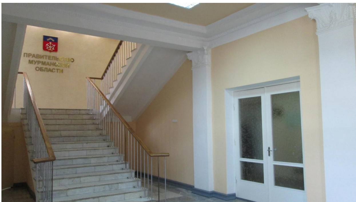
Фото 14. Трёхмаршевая лестница в центральной части здания.
