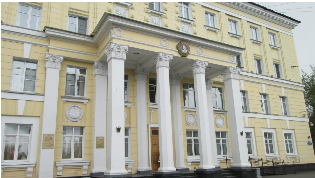
Фото 5. Западный фасад, портик южного крыла здания.
