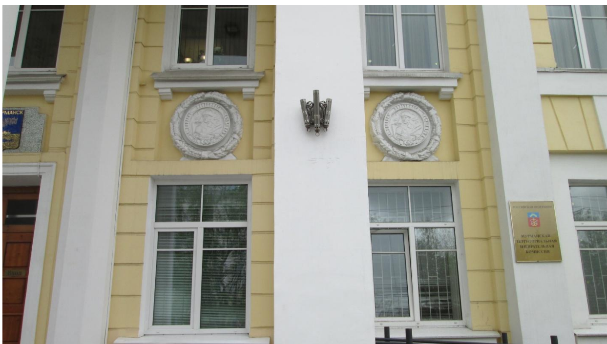
Фото 10. Барельефы на западном фасаде.
