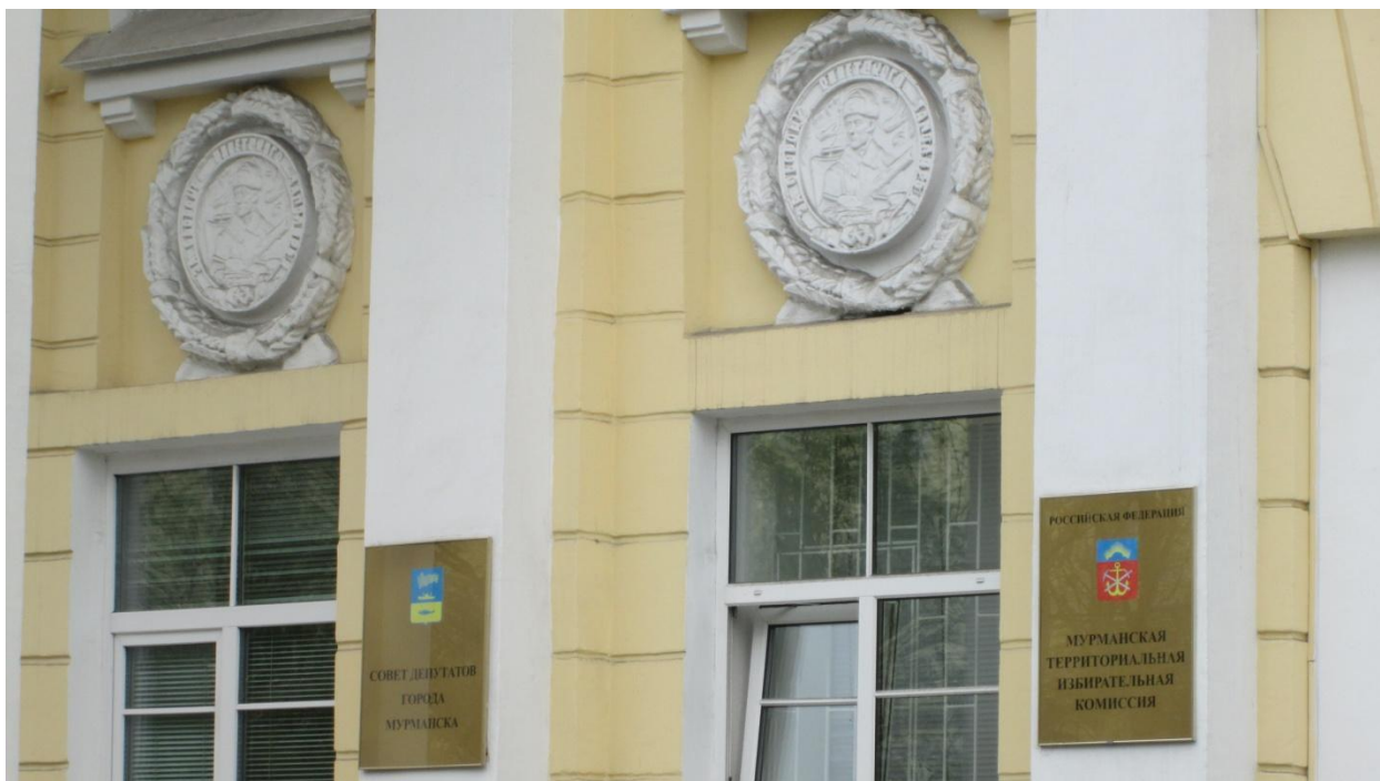
Фото 9. Барельефы на западном фасаде.
