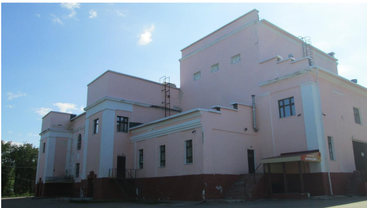
Фото 4. Общий вид с северо-запада
