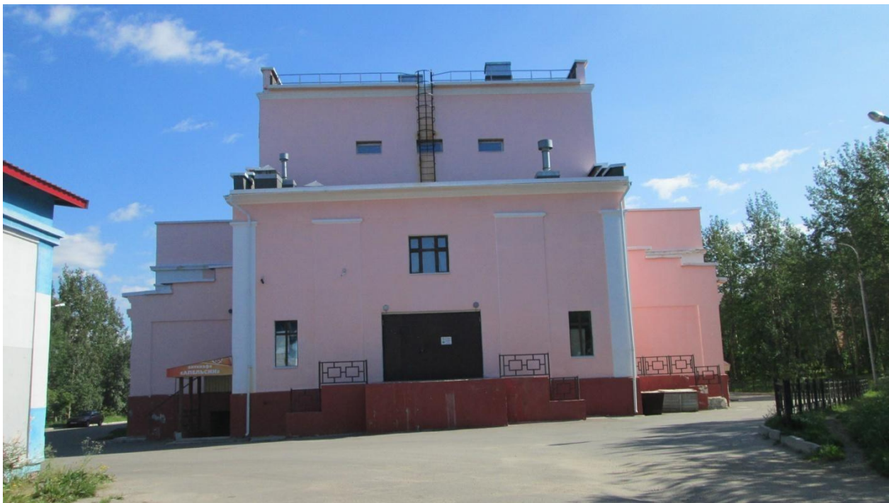
Фото 3. Западный (дворовый) фасад
