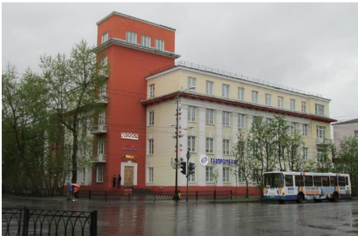
Изображение 1. Общий вид здания с севера, с перекрёстка проспекта Ленина и улицы Профсоюзов.
