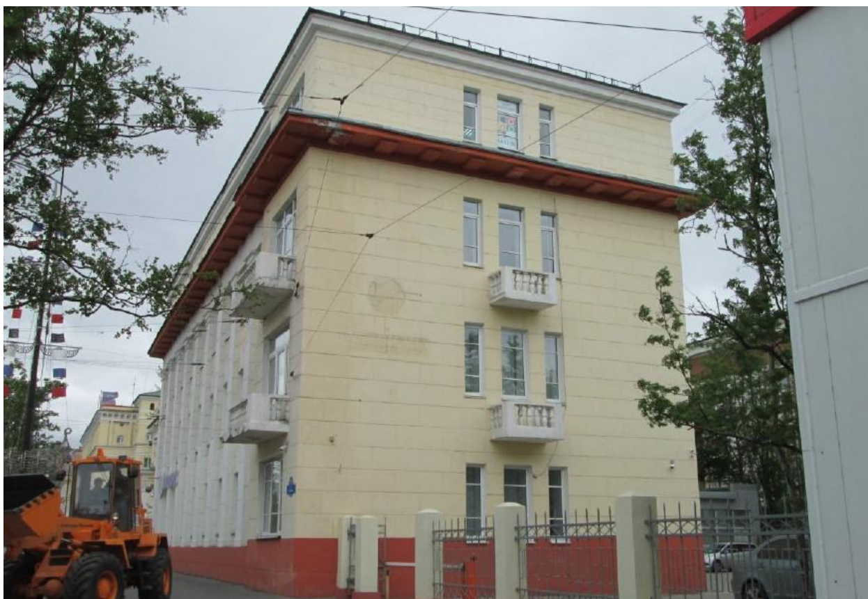
Изображение 5. Южный (юго-западный) фасад.
