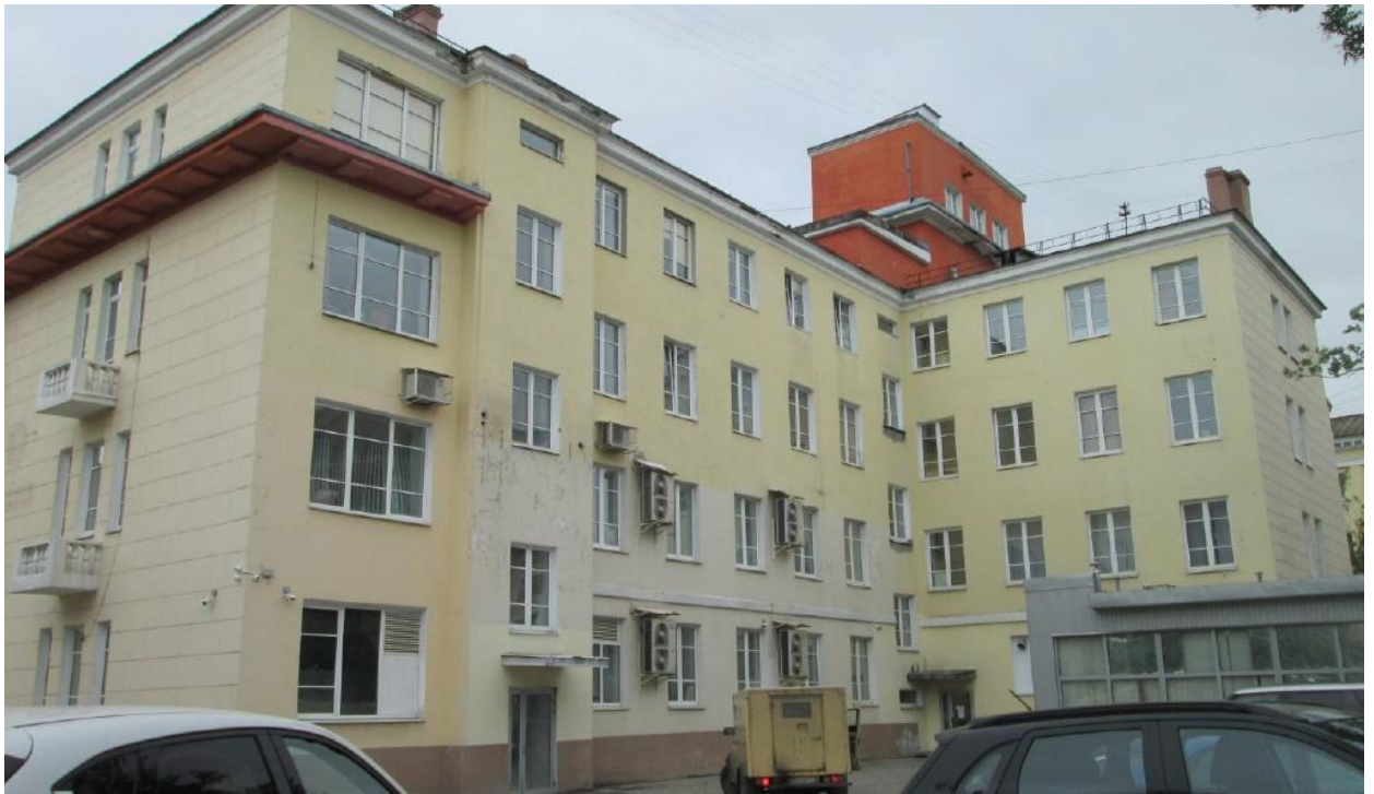
Изображение 6. Общий вид здания со двора, с южной стороны.
