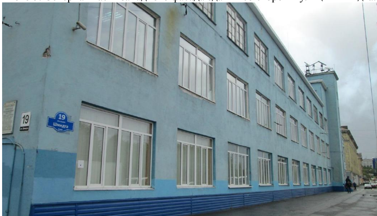
Фото 6. Западный фасад, вид с улицы Шмидта.
