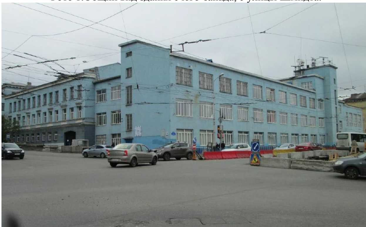
Фото 2.Общий вид здания с северо-запада, с перекрёстка улицы Академика Книповича и улицы Шмидта.
