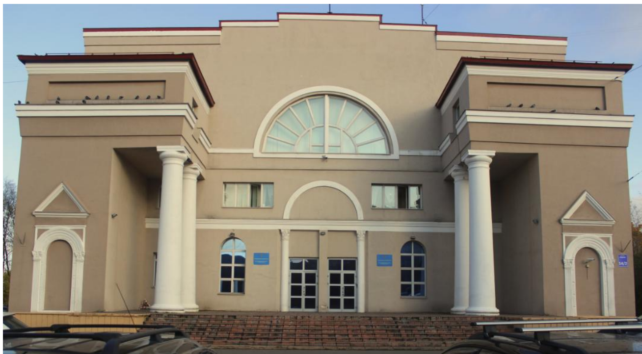
Фото 1. Юго-западный фасад, вид с ул. Кирова.
