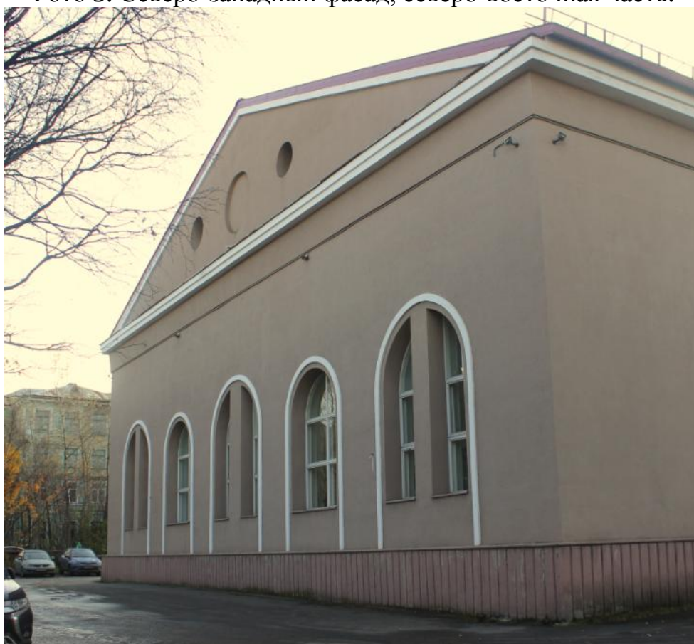
Фото 4. Северо-восточный фасад. Общий вид.
