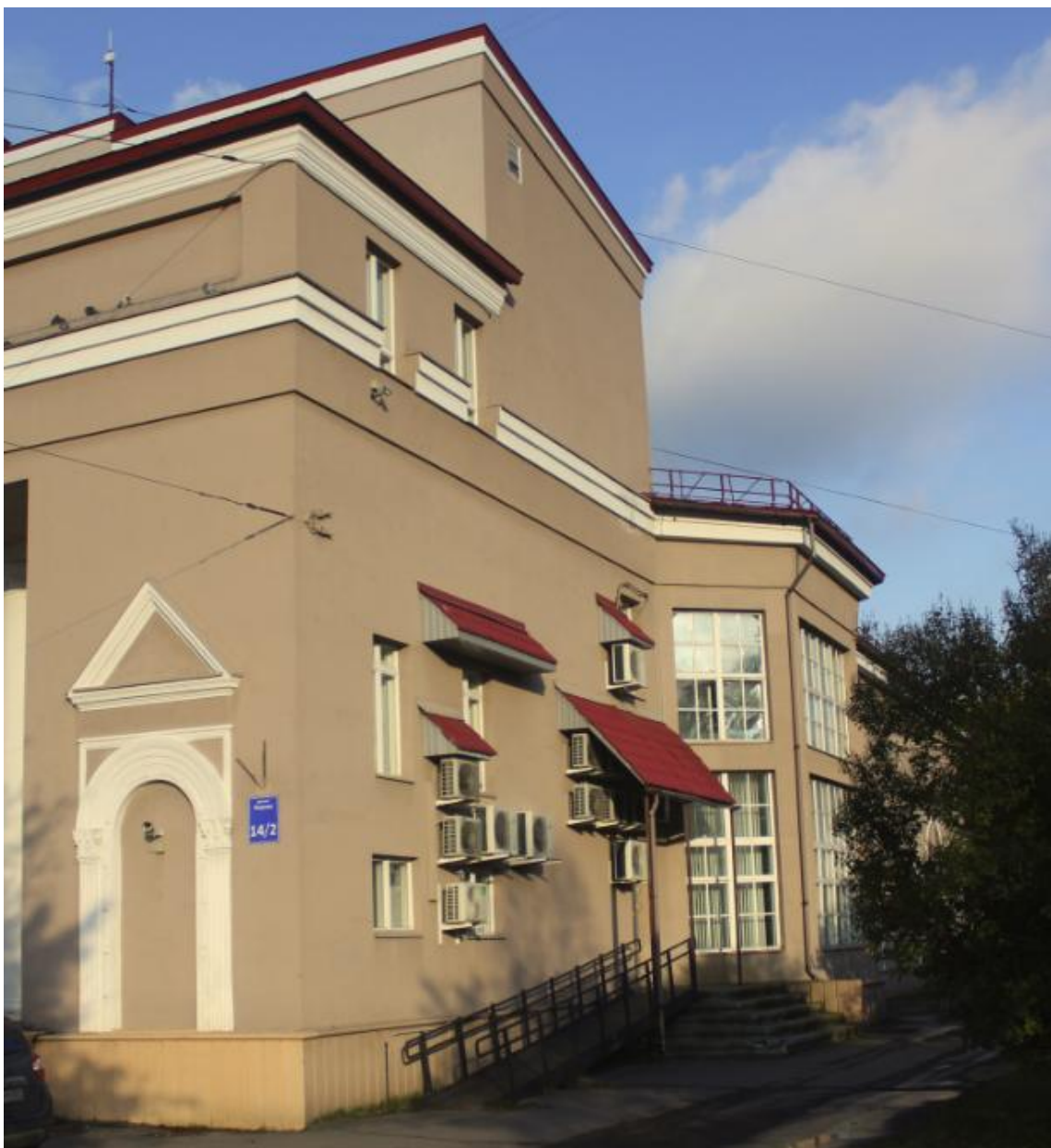
Фото 6. Юго-восточный фасад, юго-западная часть.
