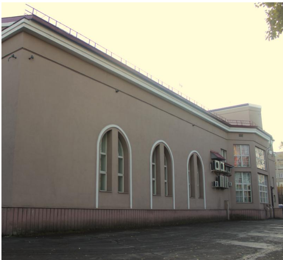
Фото 3. Северо-западный фасад, северо-восточная часть.
