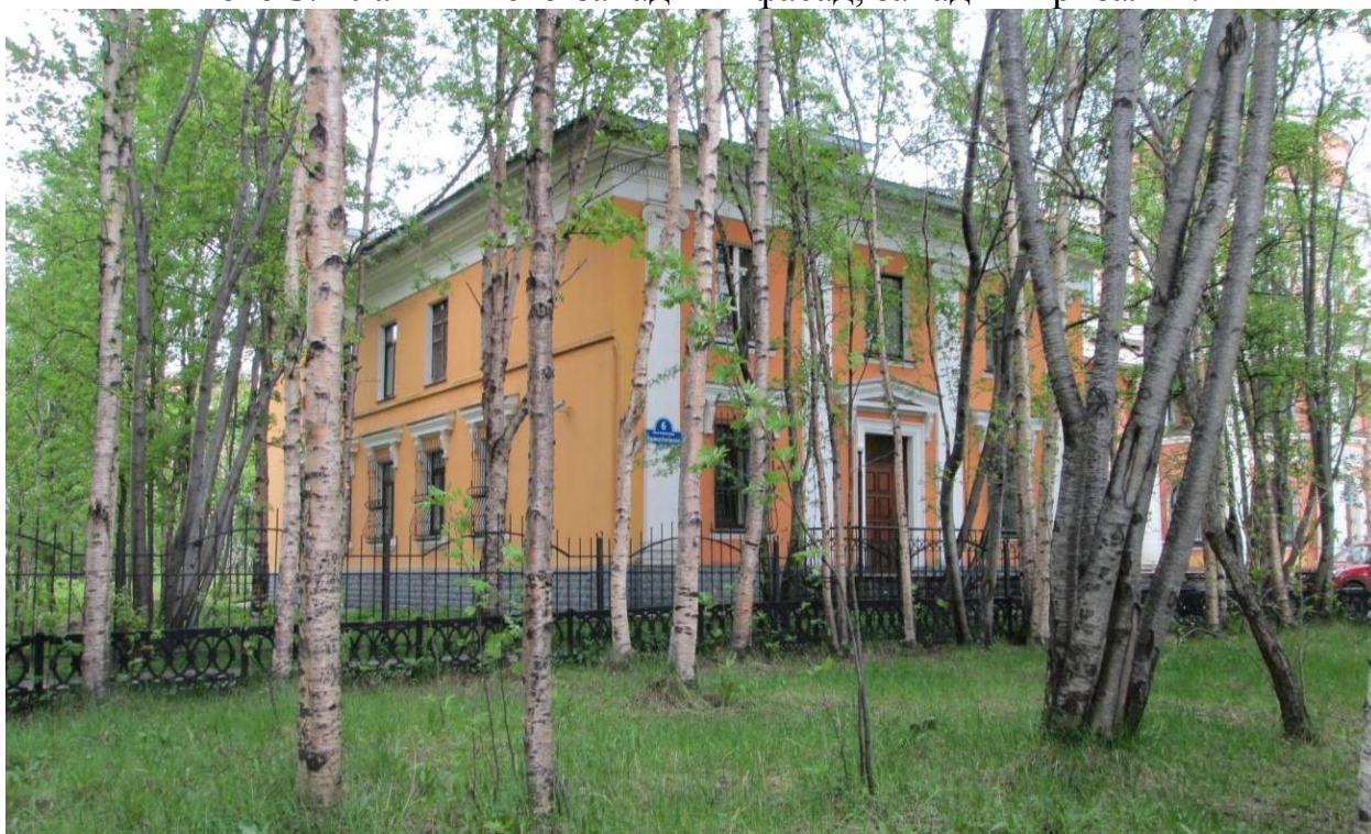
Фото 4. Северо-западный боковой фасад. Общий вид.
