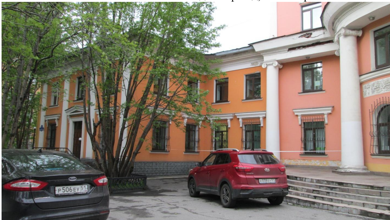
Фото 3. Главный юго-западный фасад, западный ризалит.
