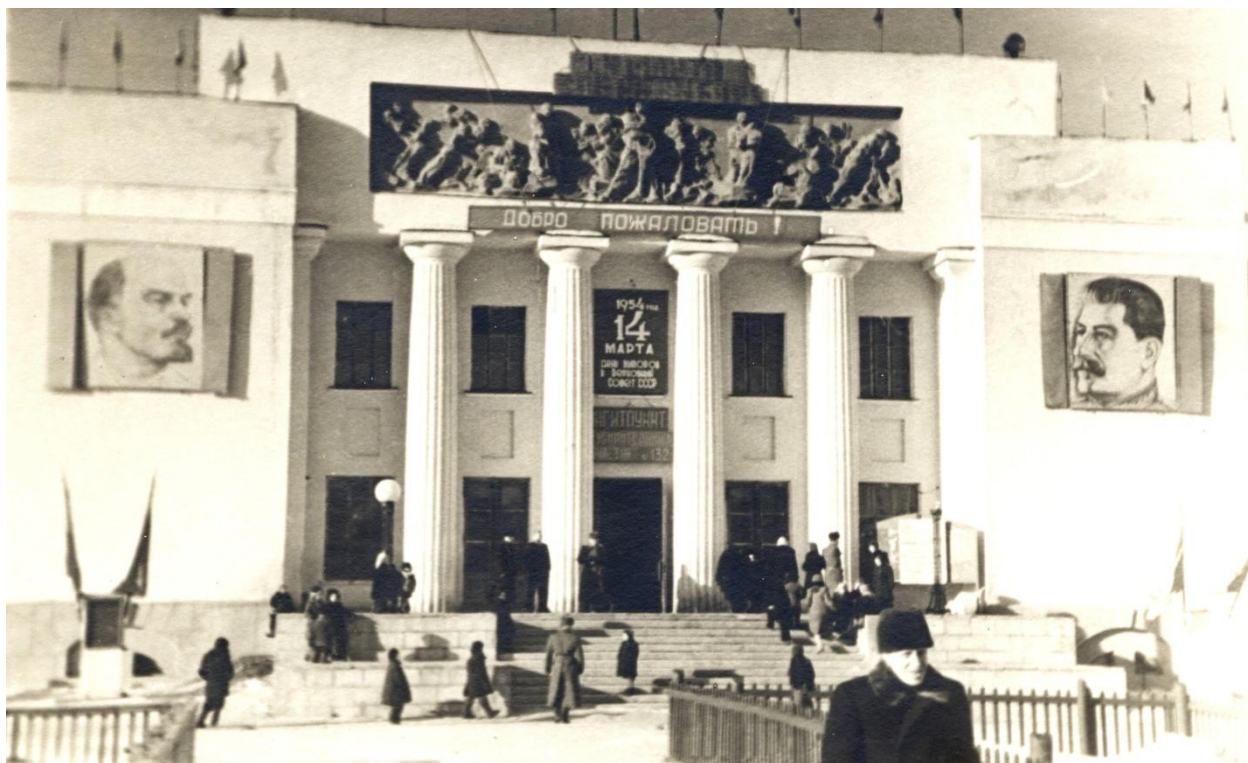
11. Главный фасад. 1954 г.
