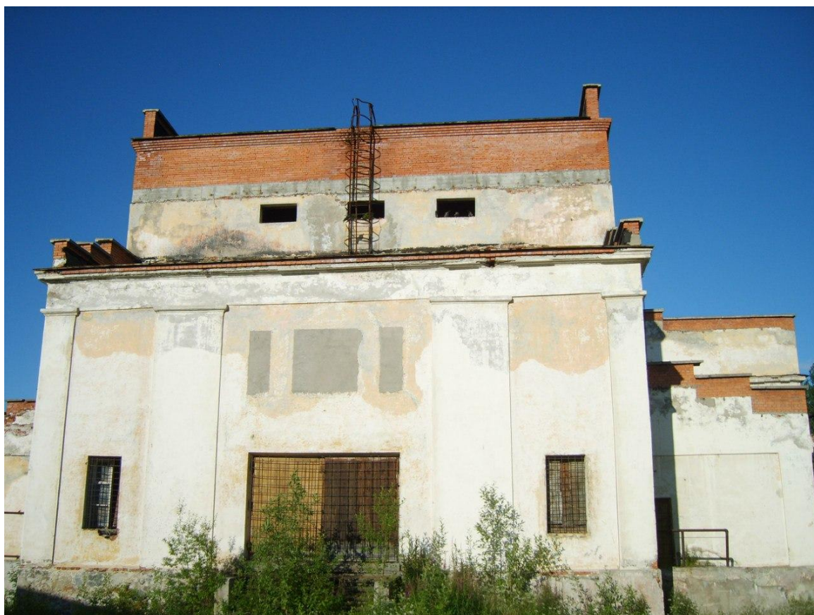
18. Дворовый западный фасад в процессе реконструкции. Фото 2000-х гг.
