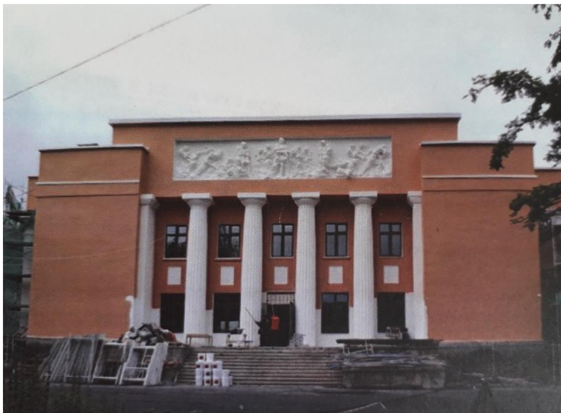
20. Главный восточный фасад после ремонта и реконструкции 2013 г.
