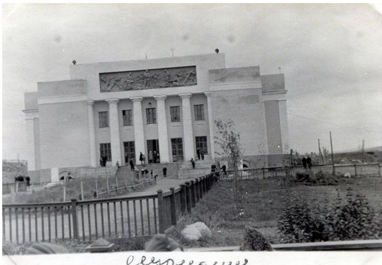
2. Общий вид здания с востока. Возможно, конец 1930-х годов.
