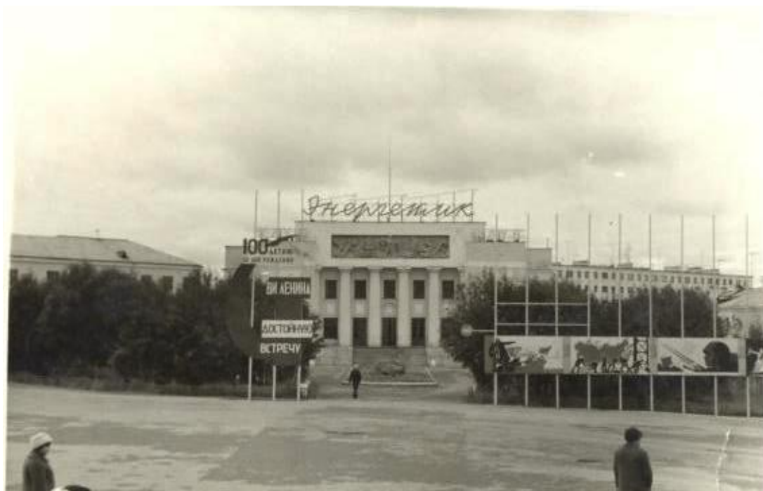
13. Общий вид с востока. 1969 г.
