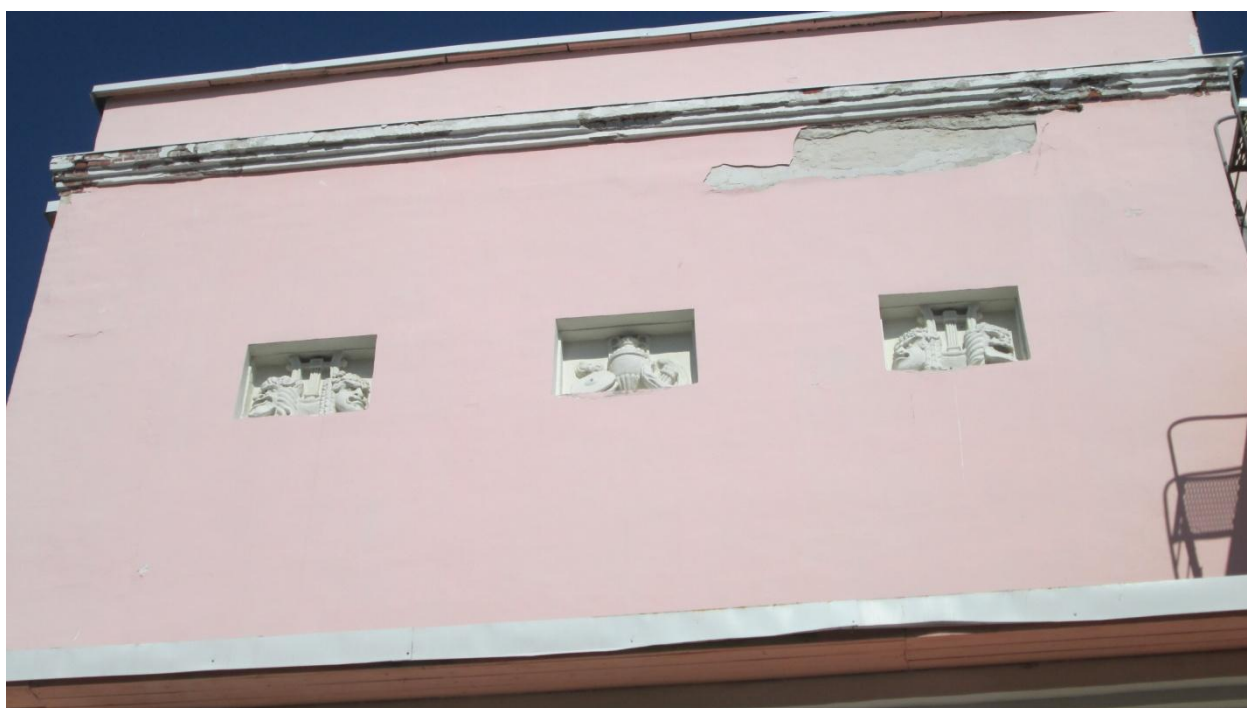
24. Барельефные скульптурные изображения в нишах на южном фасаде. Фото июль 2020 г.
