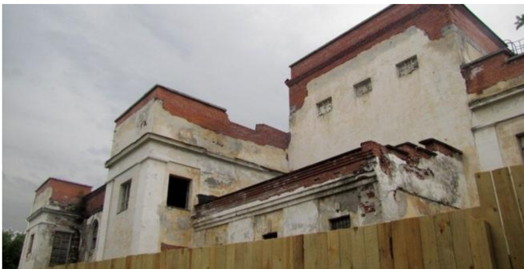
19. Северный фасад в процессе реконструкции. Фото после 2008 г.
