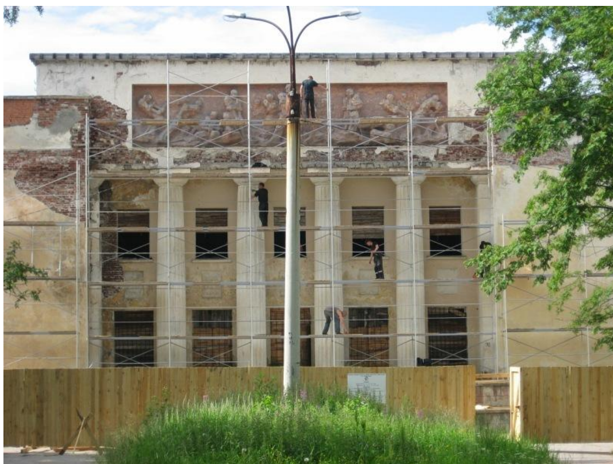
16. Ремонтные работы на главном фасаде. Фото после 2008 г.
