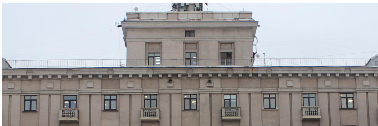
Фото 4. Профилированная тяга над окнами 6-го этажа и венчающий профилированный карниз с кронштейнами и 11 модулями
