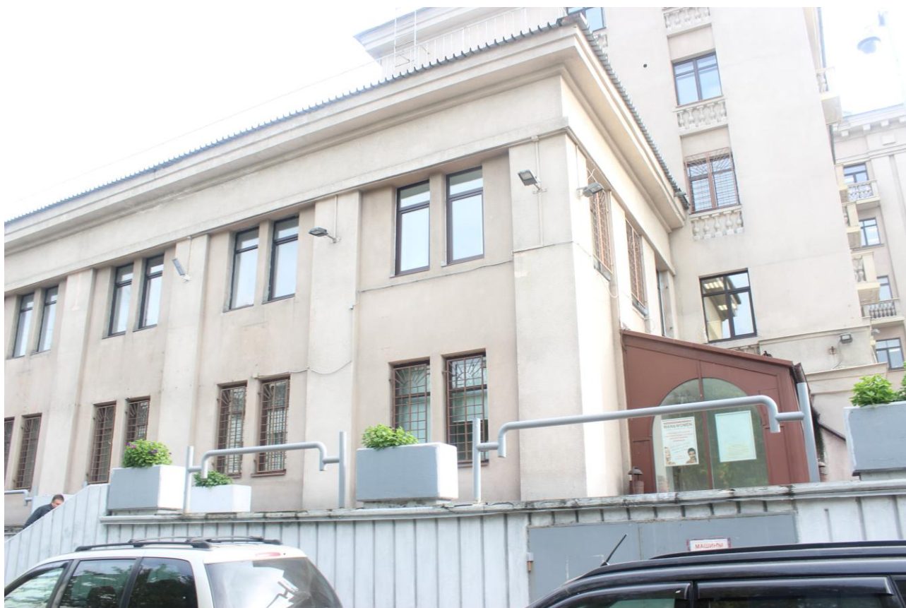
Фото 17. Двухэтажная пристройка, примыкающая к северному (пятиэтажному) объему
