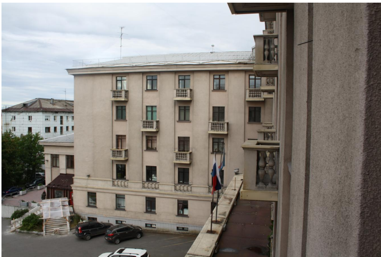
Фото 14. Южный фасад северного (пятиэтажного) объема
