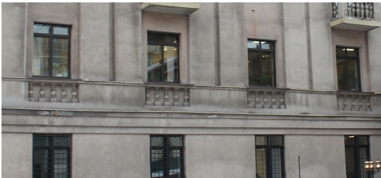
Фото 11. Междуетажный карниз между 1 и 2 этажами и подоконная тяга, расположенные в уровне 2-го этажа
