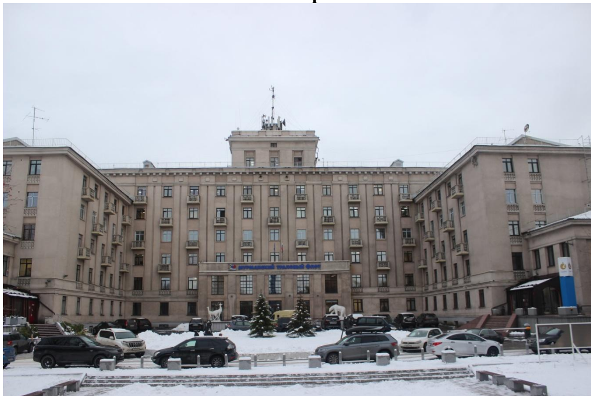
Фото 1. Западный фасад центрального (шестиэтажного) объема
