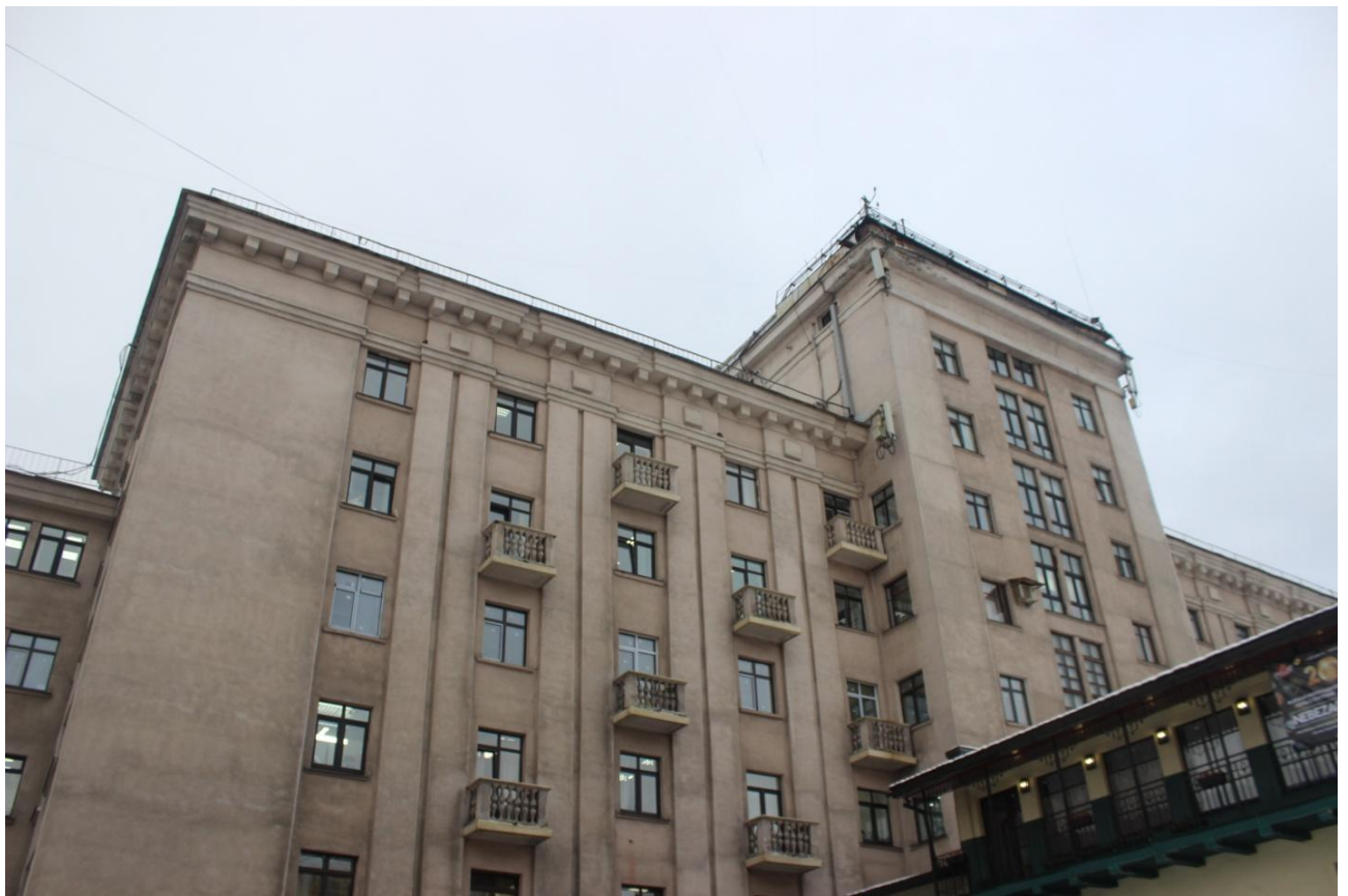
Фото 9. Южная часть восточного фасада центрального (шестиэтажного) объема
