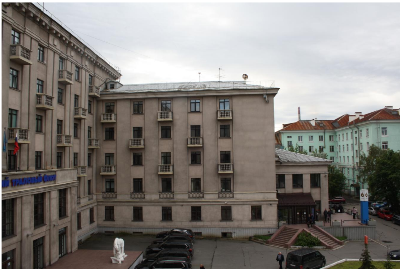
Фото 13. Северный фасад южного (пятиэтажного) объема
