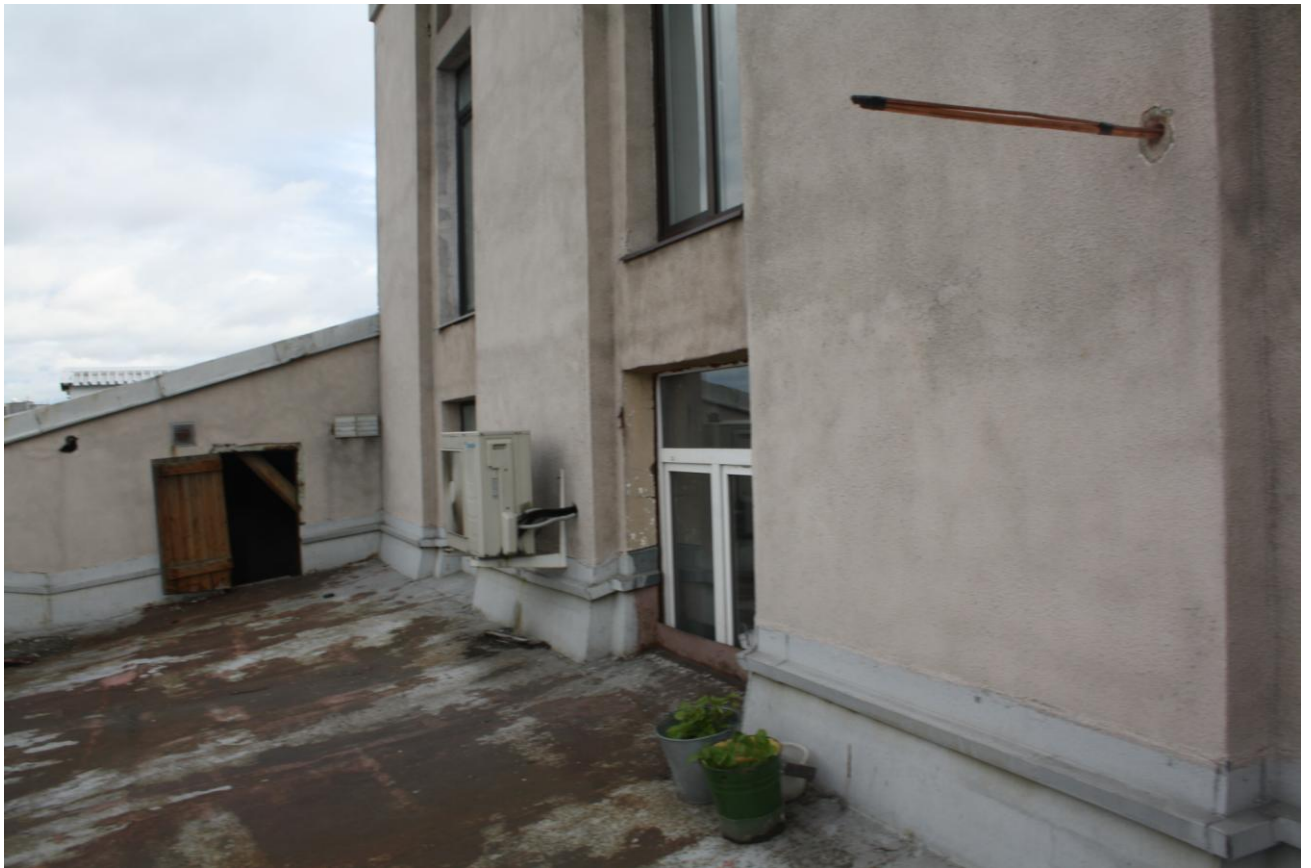
Фото 5. Оконные проемы башни на западном фасаде
