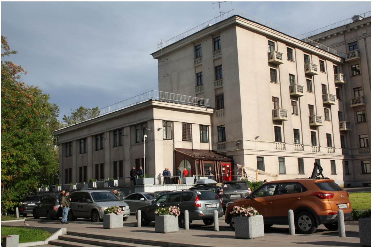
Фото 16. Двухэтажная пристройка, примыкающая к северному (пятиэтажному) объему
