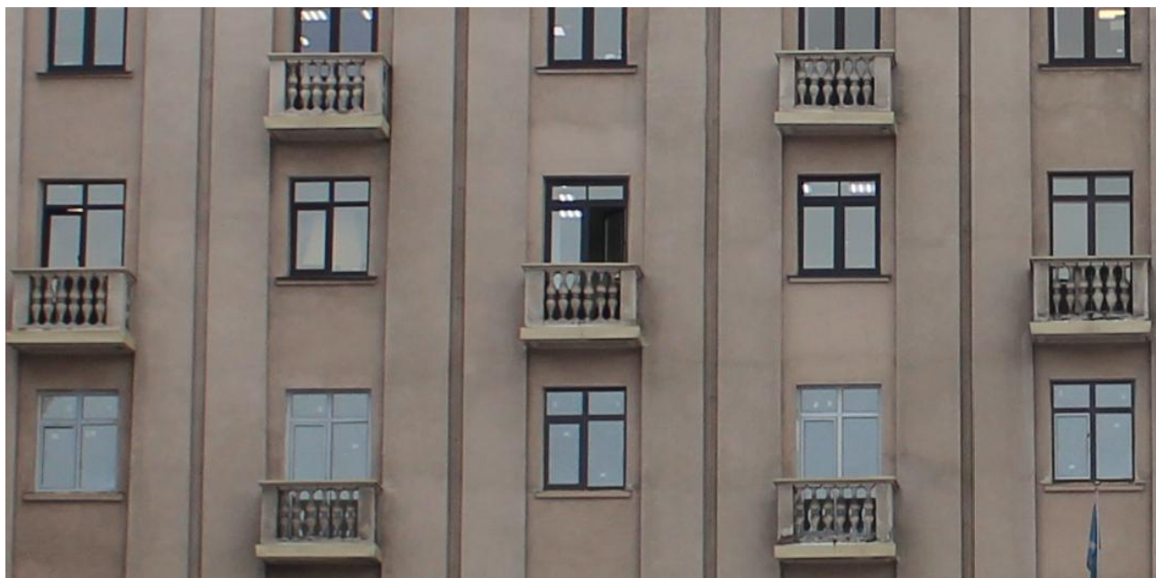
Фото 2. Западный фасад центрального (шестиэтажного) объема, оконные проемы, дверные проемы, расположенные в шахматном порядке, с формой ограждений в виде балюстрады
