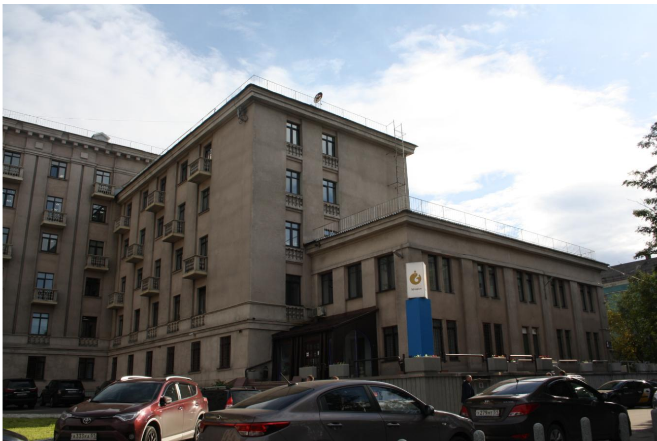
Фото 18. Двухэтажная пристройка, примыкающая к южному (пятиэтажному) объему
