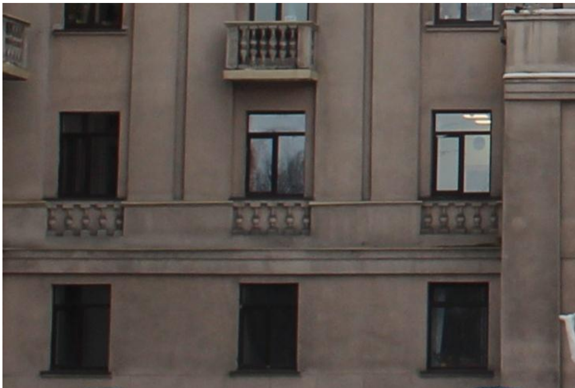
Фото 3. Междуетажный карниз, расположенный между первым и вторым этажами, подоконная тяга, расположенная в уровне 2-го этажа;
