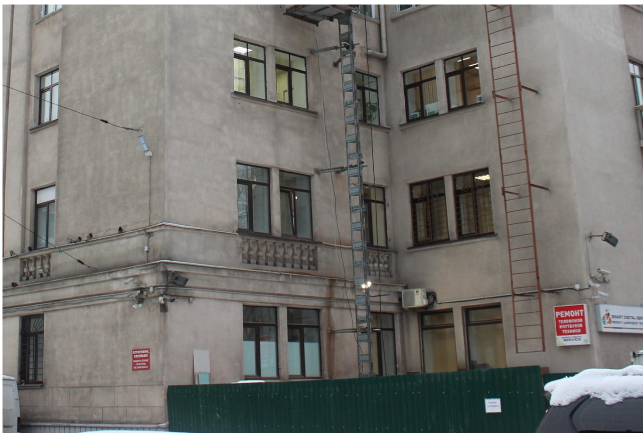
Фото 12. Сдвоенные оконные проемы; архитектурно-декоративные элементы, стилизующие изображение балюстрад; междуетажный карниз, расположенный между первым и вторым этажами, подоконная тяга, расположенная в уровне 2-го этажа;
