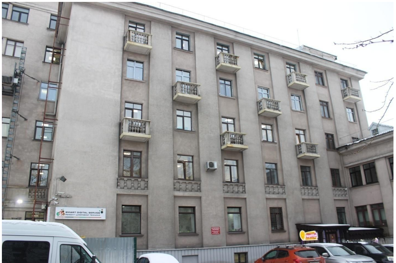
Фото 15. Северный фасад северного (пятиэтажного) объема
