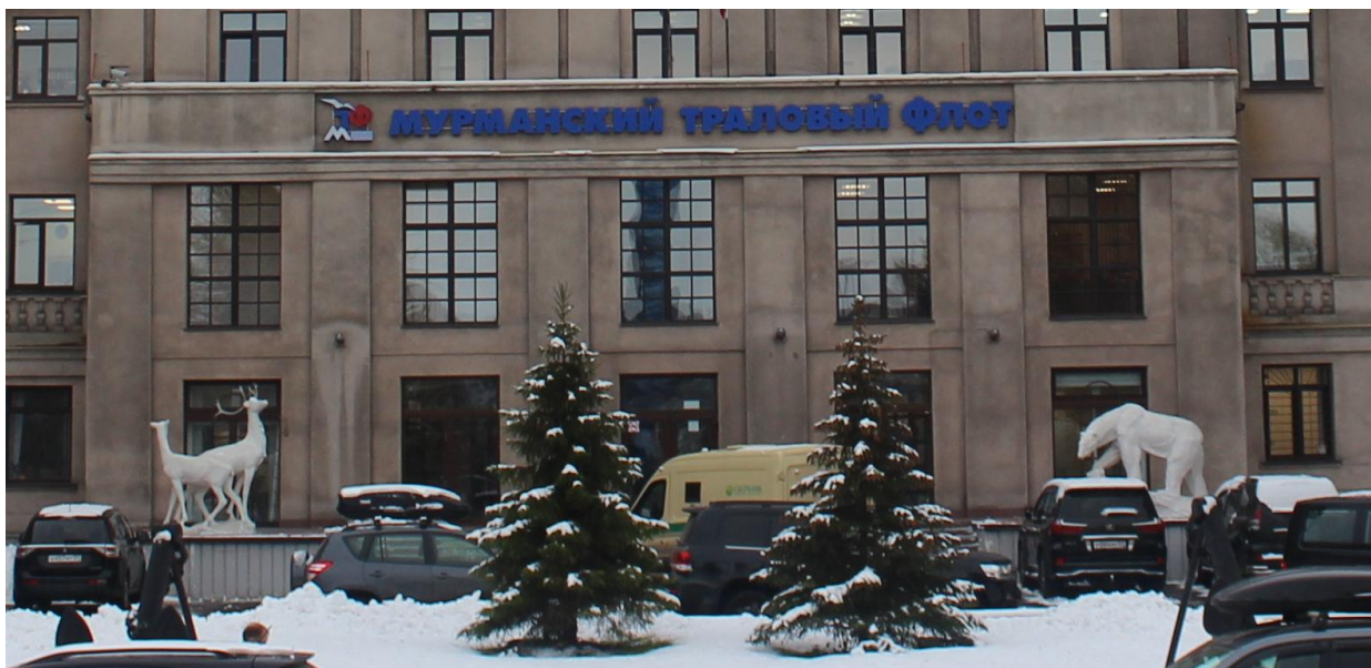
Фото 7. Двухэтажная входная группа, включающая в себя 9 оконных проемов, 1 дверной проем, венчающий профилированный карниз, фриз, 4 одинарных лопаток между осями проемов
