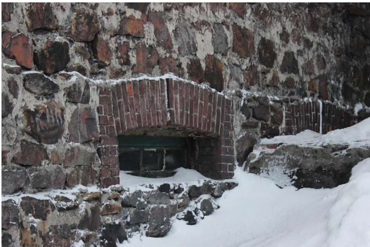
Фото 14. Деталь западного фасада. Кирпичные перемычки проёмов.
