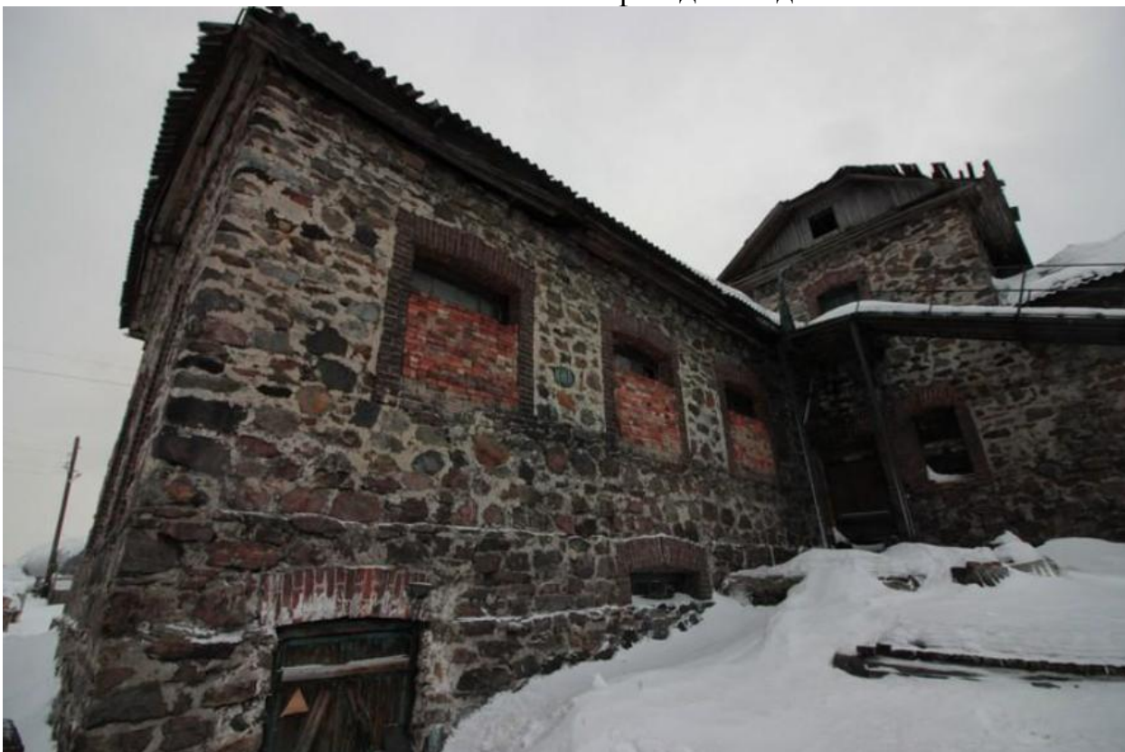
Фото 3. Вид с северо-запада.
