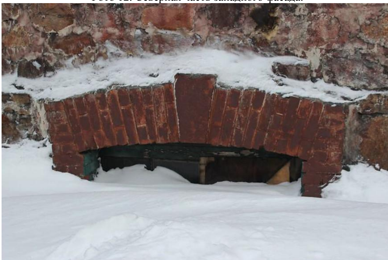
Фото 13. Деталь южного фасада. Кирпичная перемычка проёма с замком.
