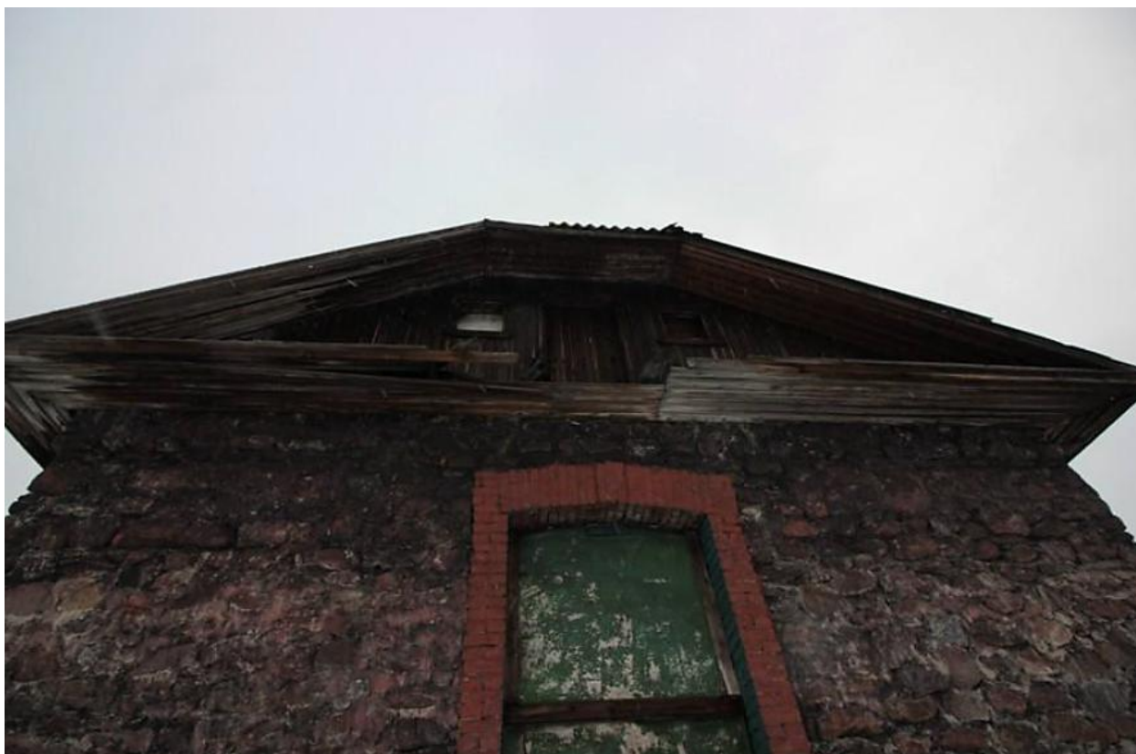
Фото 16. Фрагмент западного фасада. Деревянный фронтон с карнизами и кирпичный наличник проёма с лучковой перемычкой.
