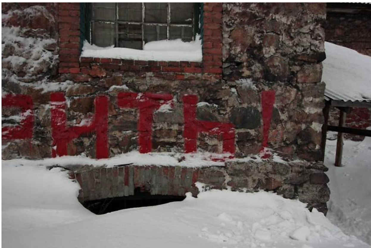
Фото 18. Деталь восточного фасада. Кирпичная перемычка проёма цокольного этажа и кирпичный наличник оконного проёма 1-го этажа.
