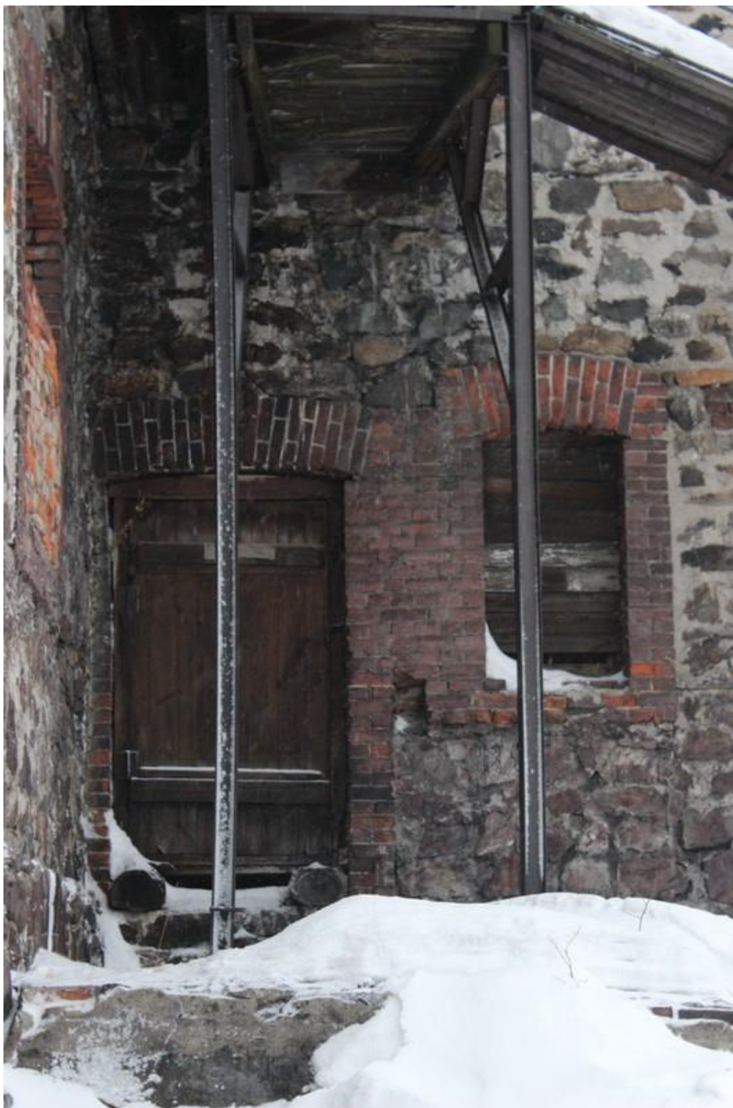
Фото 19. Деталь северного фасада. Дверной и оконный проёмы с кирпичными наличниками и лучковыми перемычками.
