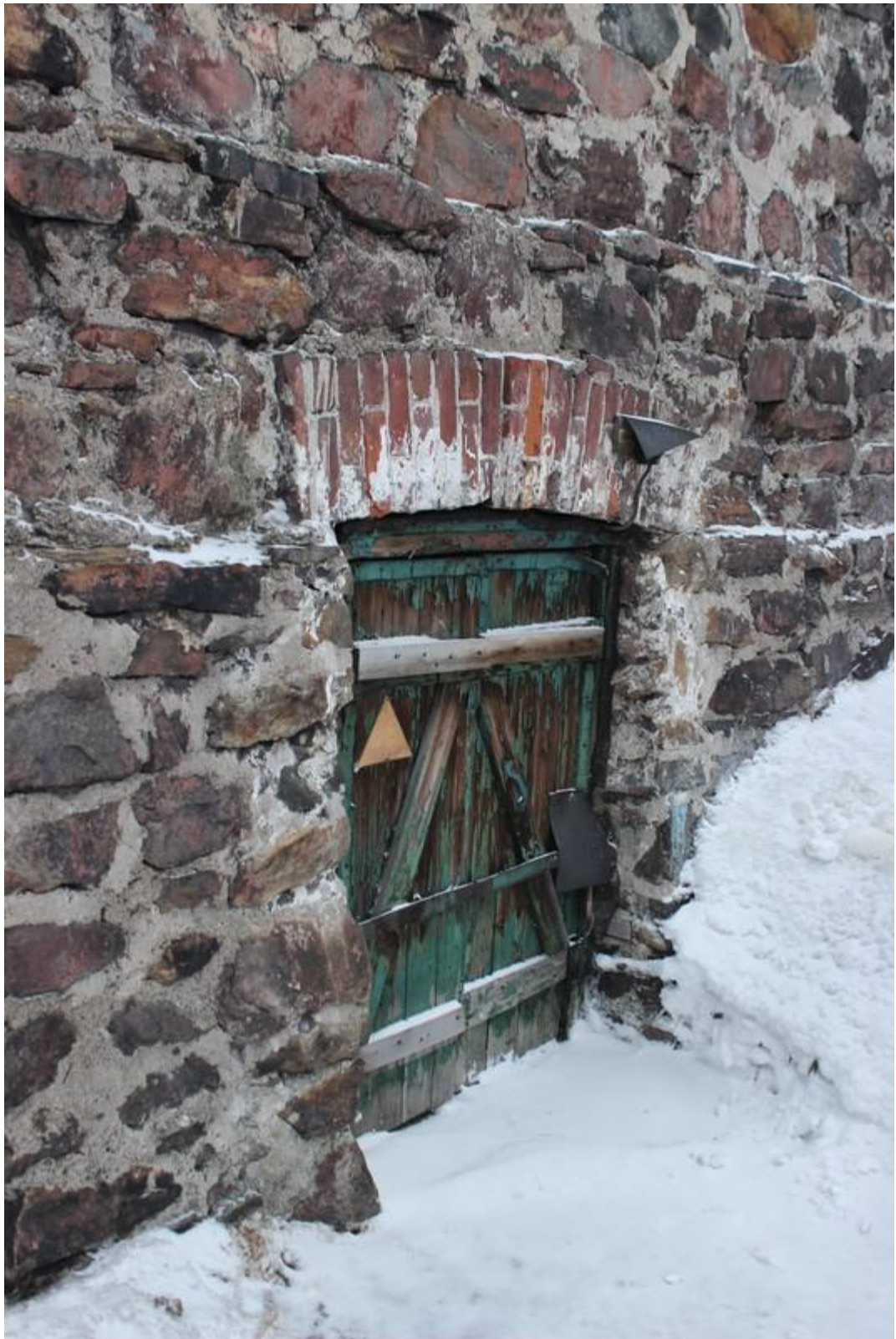
Фото 20. Западный фасад. Входной проём цокольного этажа с кирпичной лучковой перемычкой.
