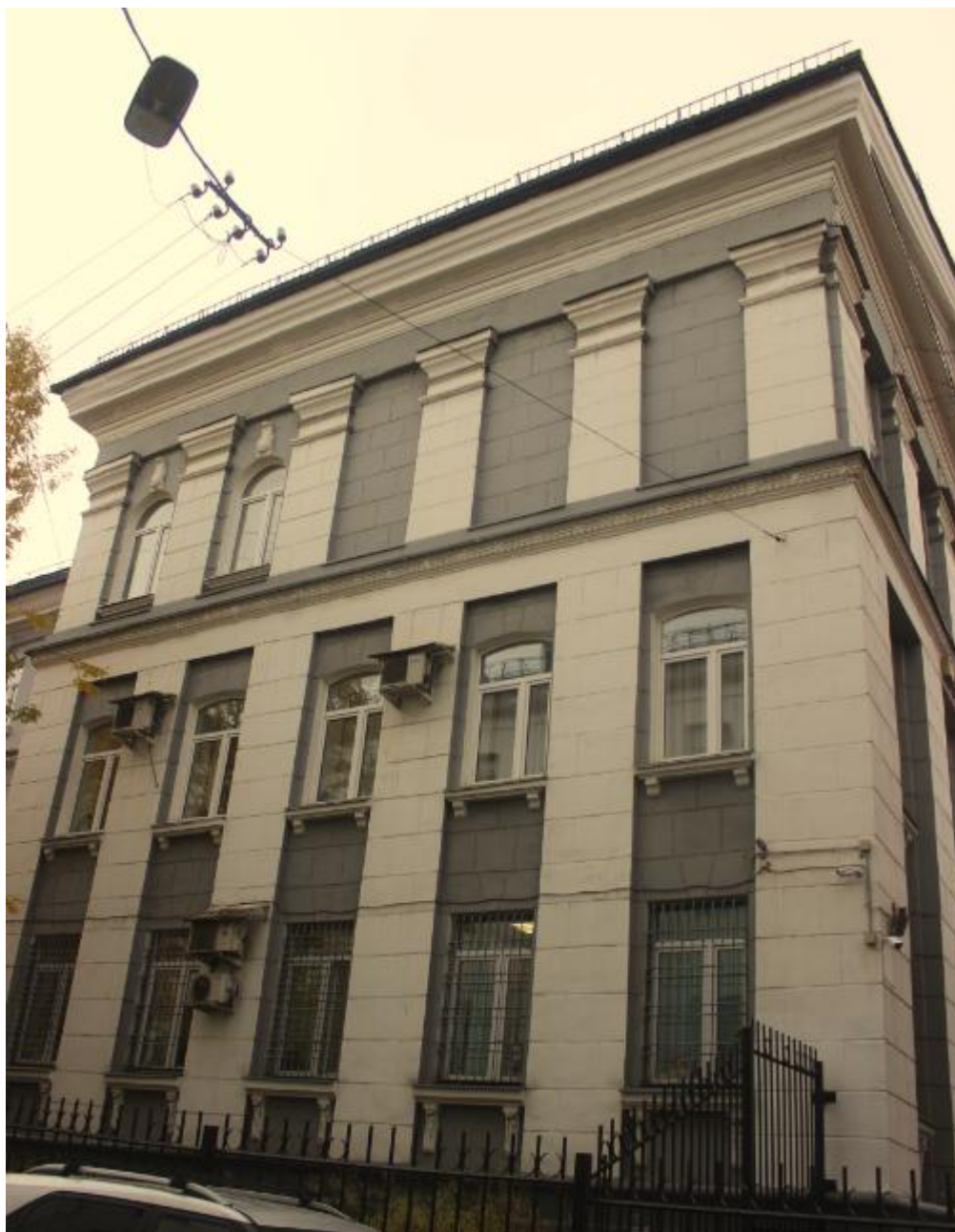
Фото 3. Юго-западный фасад, северная часть.
