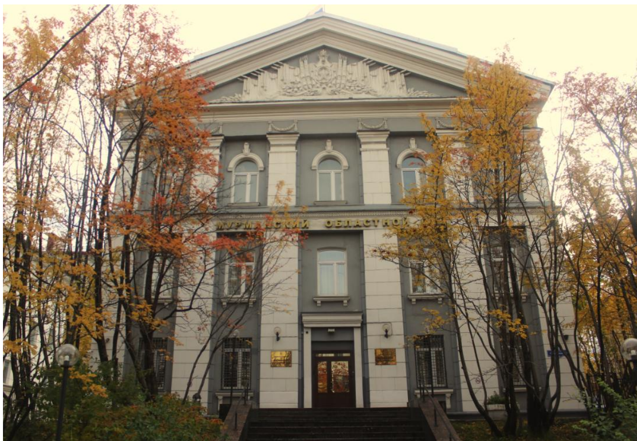
Фото 1. Северо-западный фасад, общий вид.
