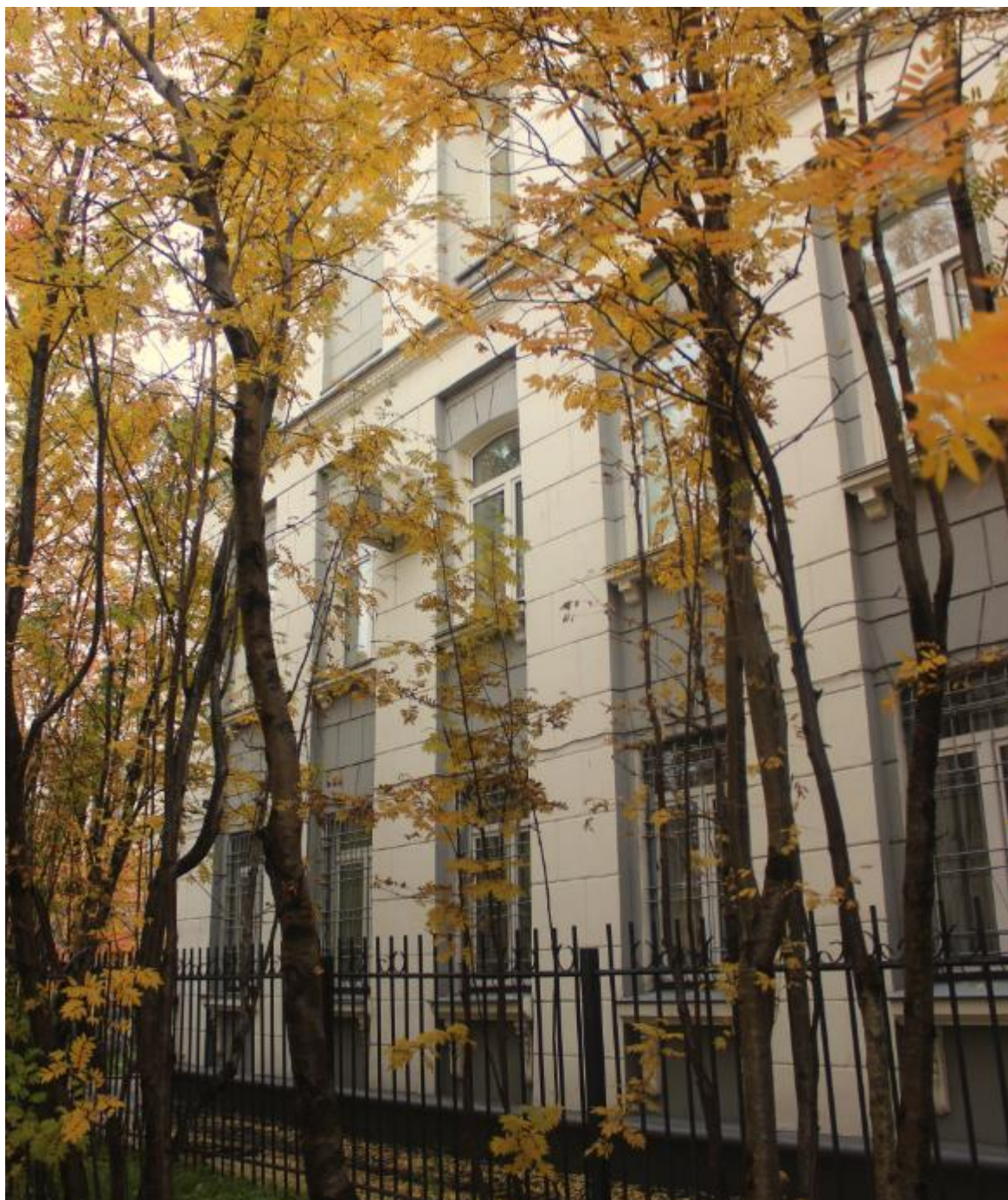
Фото 2. Северо-восточный фасад, северная часть. Общий вид.
